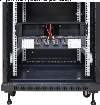
Rys.3. Sposób wsunięcia akumulatorów.
