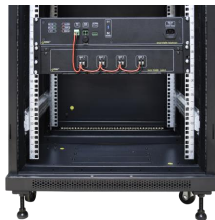
Rys.4. Podłączenie do zasilacza.
